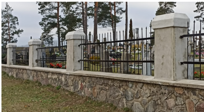
Buivydžių k. kapinių tvoros remonto II etapo darbai. Vertė – 76 835,00 Eur.
