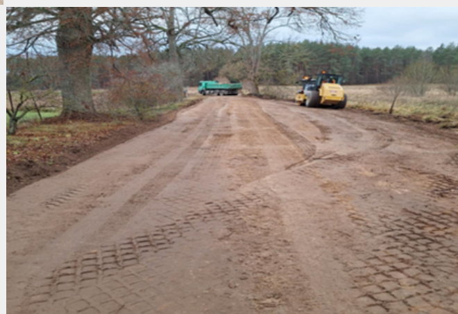
VL 3119 Šukiškių kaime atliktas kelio žvyro dangos remontas (420 m). Vertė – 33750 Eur.
