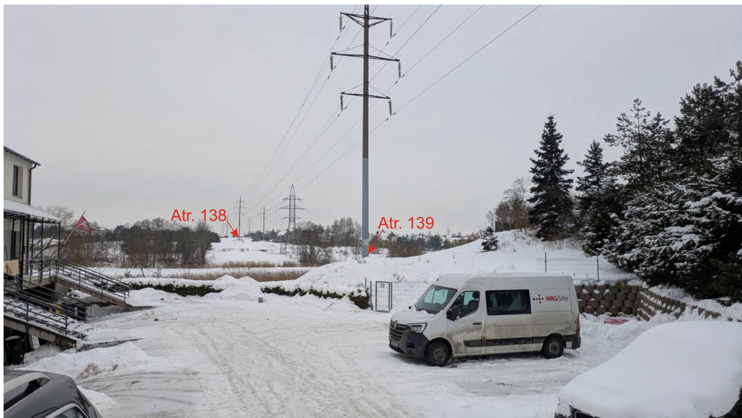
5 pav. Rekonstruojamos elektros linijos ruožas tarp atr. Nr. 138 ir Nr. 139. Vaizdas iš PR. 2026-02-05
