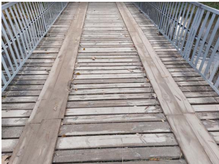
2 pav. Važiuojamoji tilto danga
