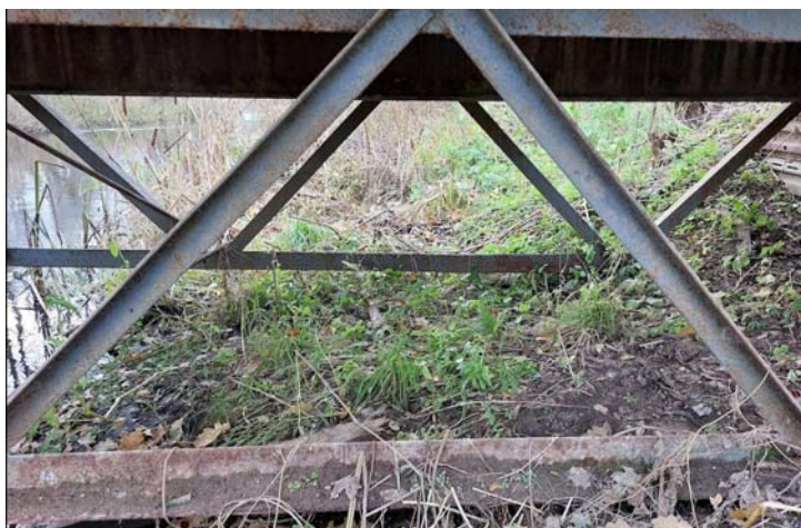
6 pav. Juosta užpilta dalinai gruntu
