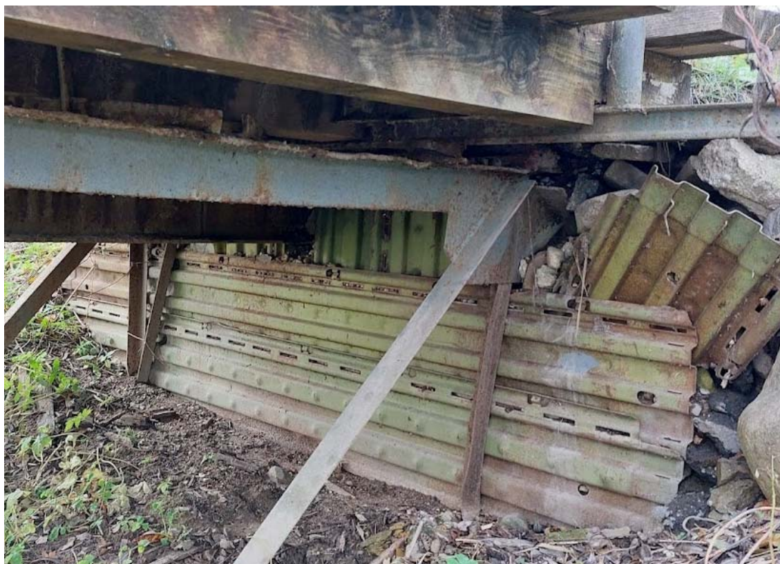
10 pav. Krantinė atrama uždengta metaliniais lakštais
