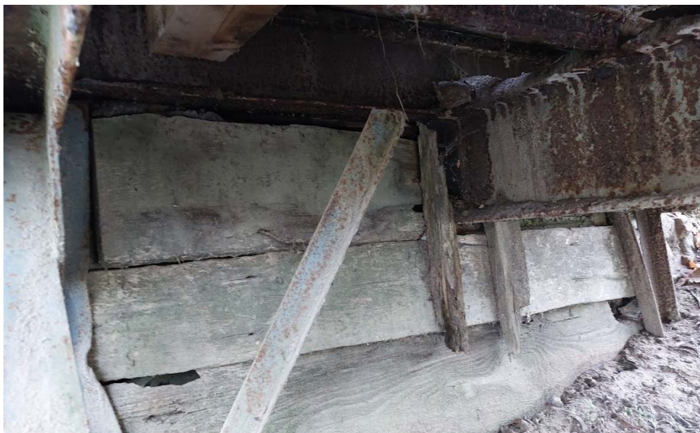
11 pav. Krantinė atrama uždengta medinėmis lentomis
