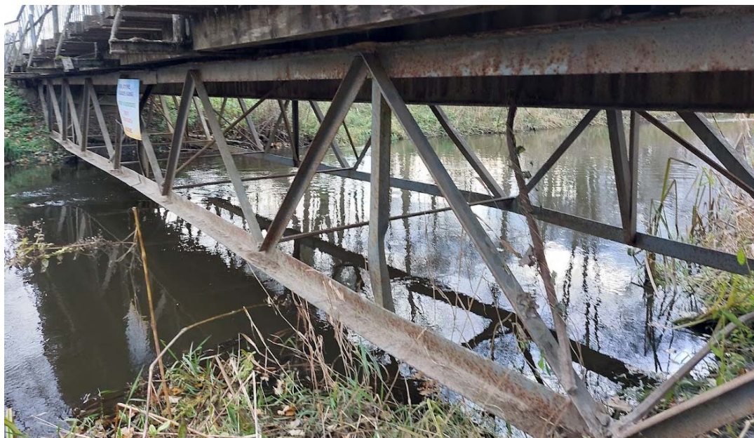
5 pav. Metalinė santvara
