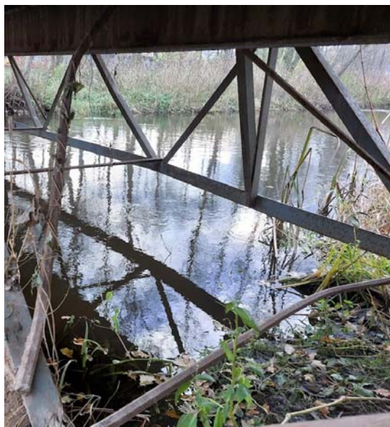
9 pav. Deformuoti elementai
