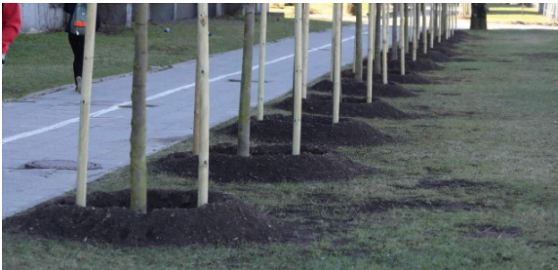
7 pav. Pasodintų medžių duobutės, skirtos laistymui paruošimas.
